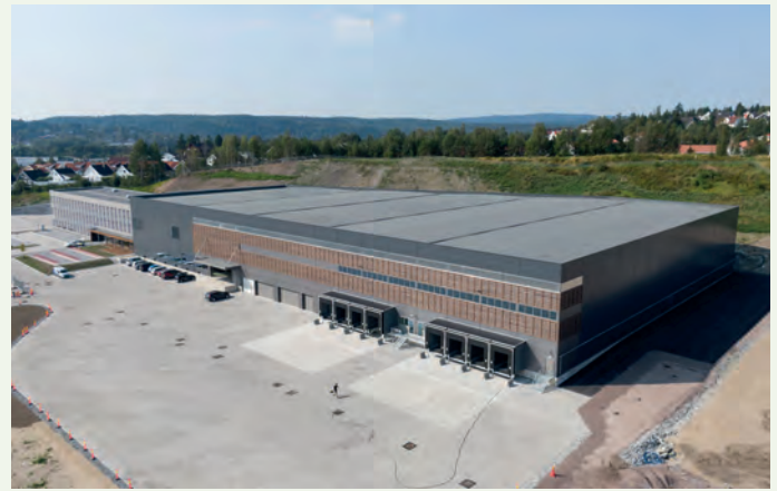
Betonmast startet arbeidet med takking av det 7.750 kvadratmeter store taket på samme tid som snøværet satte inn.
