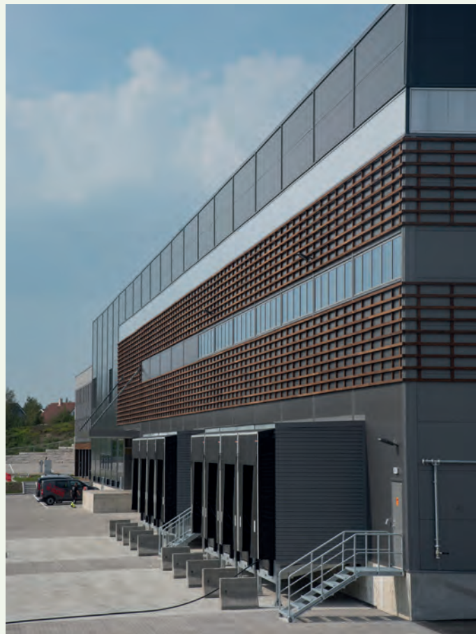
Lager- og produksjonsdelen mot nordøst.
