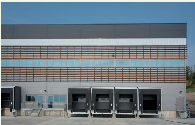
Fasadene har liggende Paroclementer i to fargenyanser, med et horisontalt felt av polykarbonat oppe.
